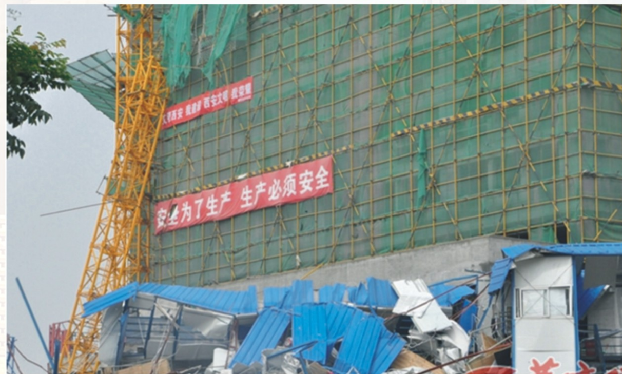
▲ 塔吊安装避开生活区办公区及高压线覆盖范围
