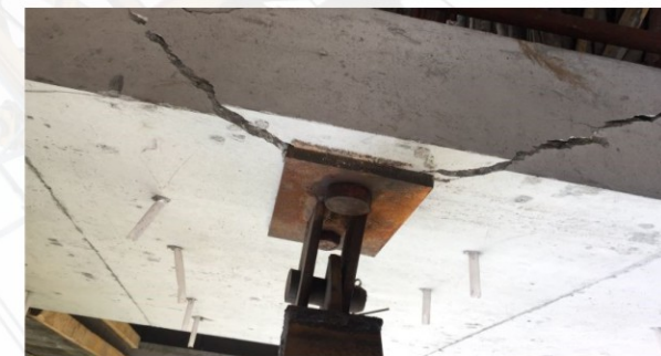
塔吊附着预埋件要在主钢筋的内侧，附着安装好加强观察
